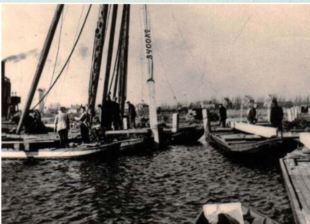
De bouw van de Noorderhemweg.
